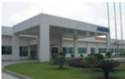
アイシン精機 佛山車体部品有限会社 2006年5月より電動サンルーフ、パワーシートのもーターハウジングの生産を開始。
